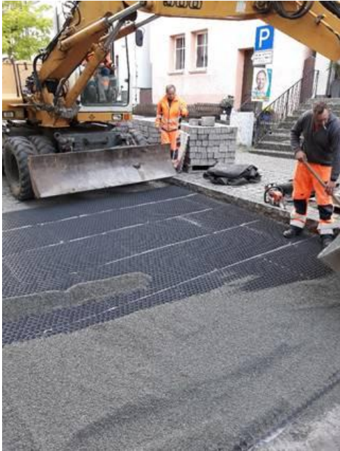
Verfüllen der Waben mit Pflastersplitt
