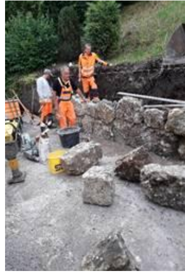
Aufbau der Mauer
